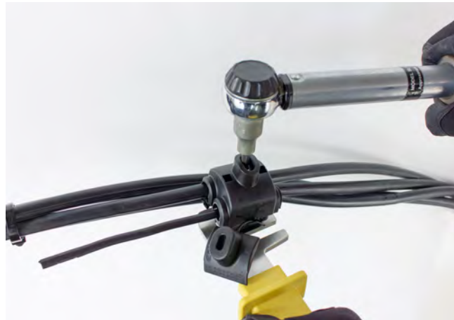
Dokręcanie zacisku SL11.118 za pomocą klucza dynamometrycznego.
