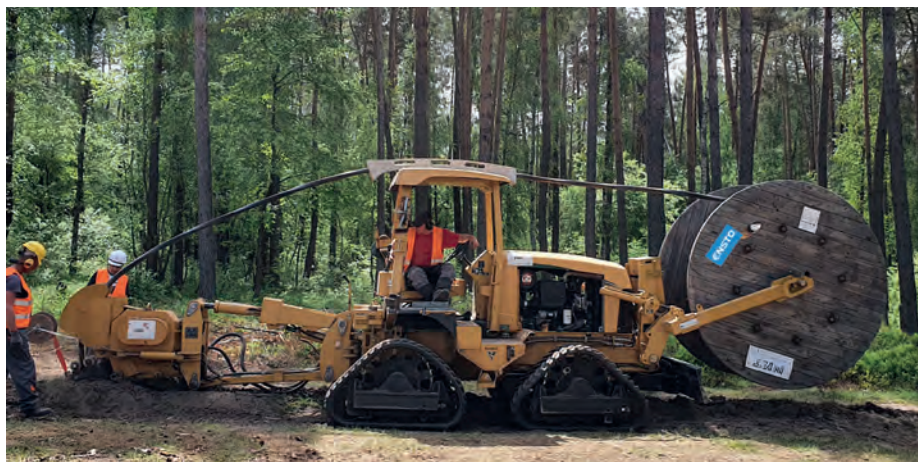
Układanie kabla AXAL-TT PRO pługiem wibracyjnym
