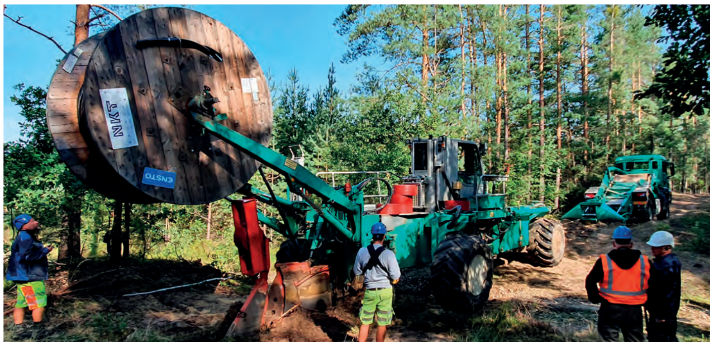
Układanie kabla AXAL-TT PRO pługiem ciągnionym
