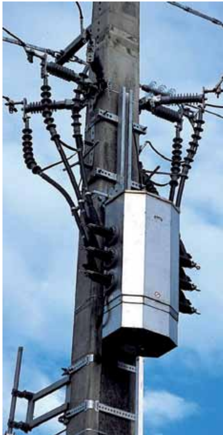
Condamnation de l'interrupteur de neutralisation
