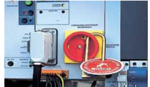
Condamnation de l'interrupteur de neutralisation
