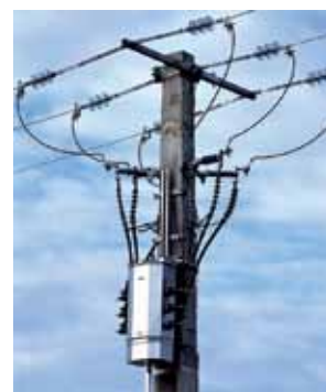
AUGUSTE installé sous la ligne
